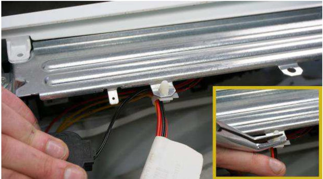
© diybook | Als nächstes wird die Kabelsicherung der Bedienplatte mit Hilfe einer Spitzzange vorsichtig gelöst.
