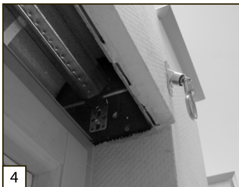
Schritt 4 Befestigen Sie nun die Gelenkplatte am Mauerwerk
