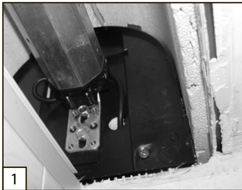
Schritt 1 Montieren Sie zunächst den Rohrmotor im Rollladenkasten.
